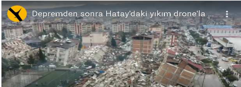
Bild: Anadolu Ajansı / Mit Dronen Aufnahmen in Antakya
